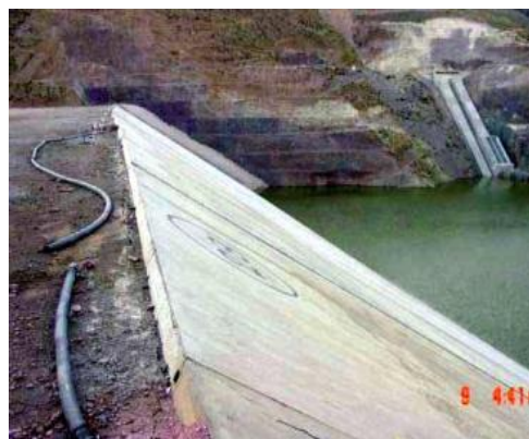
شکل ۳ - نمایشی از سدهای سنگریزه ای با رویه بتنی CFRD و هسته رسی ECRD
