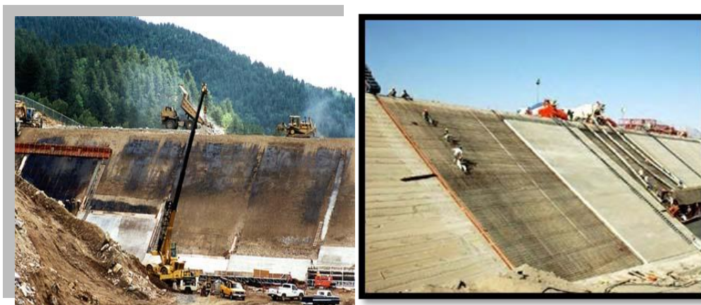
شکل ۵-۵- اجرای رویه بتنی در سدهای سنگریزه ای CFRD
