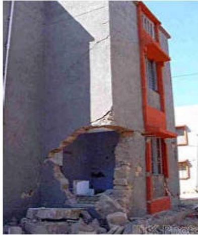
شکل ۱-۳: خسارت ناشی از خرابی دیوار آجری (محمد زاده، ۱۳۸۶)
