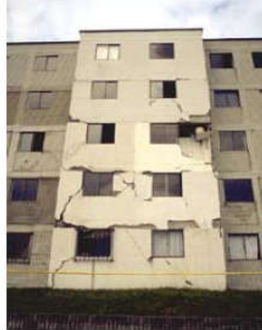
شکل ۱-۳: خسارت ناشی از خرابی دیوار آجری (محمد زاده، ۱۳۸۶)
