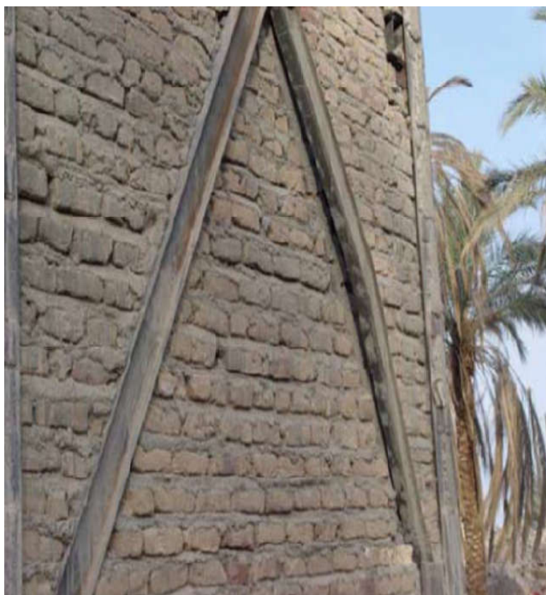
شکل ۱-۵: نمونه عملکرد قاب مهاربندی و میانقاب در زلزله بم (محمدعلی، ۱۳۹۱)
