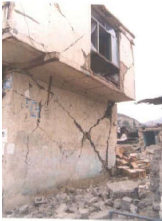
شکل ۱- ۴: نمونه عملکرد مرکب قاب و میانقاب در زلزله رودبار و منجیل (محمدعلی، ۱۳۹۱)
