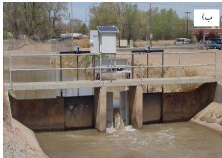
شکل ۱- نمای دریچه سالونی، (الف) پلان، (ب) نمای پایین دست [۴]
