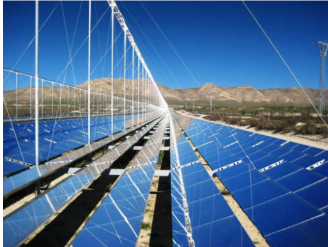
شکل ۱-۲: نمایی از انعکاس دهنده خطی فرنل.
