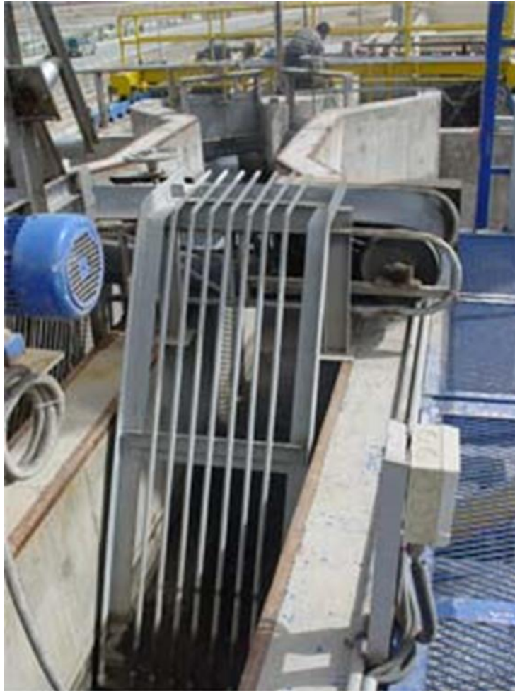
شکل ۲. صاف کردن فاضلاب با آشغالگیری
