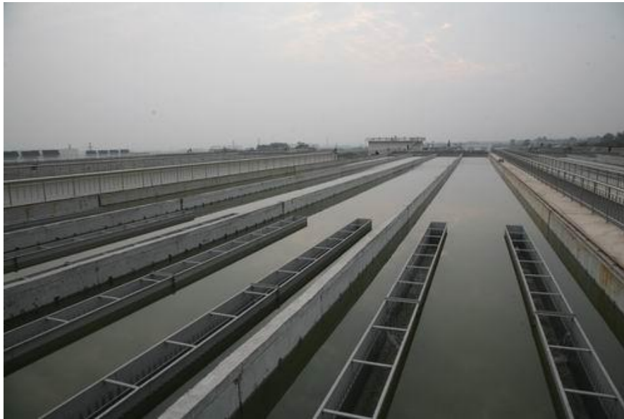
شکل ۴. نمایی از یک حوضچه‌ی ته‌نشینی مستطیلی با طول زیاد
